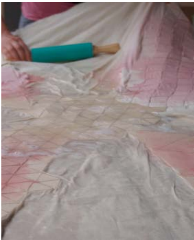
Das Verteilen und Einarbeiten des Kunststoffs
